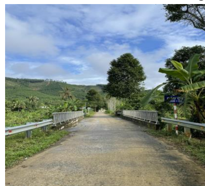
Cầu đường bộ
