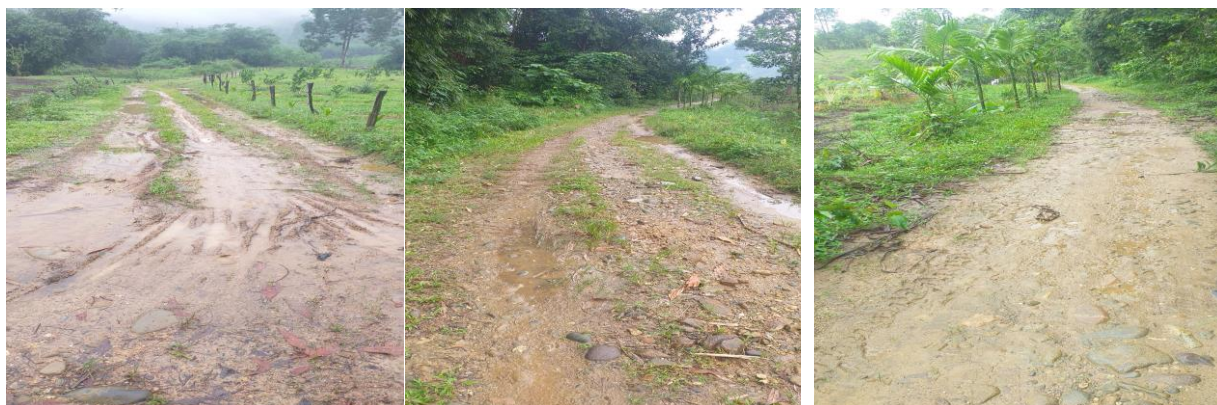
Đường giao thông phục vụ sản xuất của xã Hương Hữu
