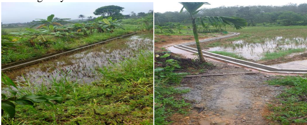
Hệ thống thủy lợi phục vụ sản xuất của xã Hương Hữu
